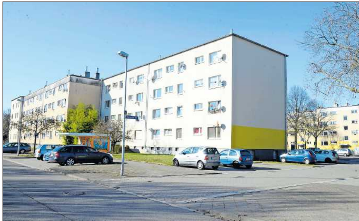
Bayreuther Straße in West: Fast 500 Menschen leben in den sanierungsbedürftigen Wohnblöcken. ARCHIVFOTO: KUNZ
