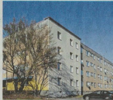
Die Gebäude in der Bayreuther Straße sollen saniert werden.
