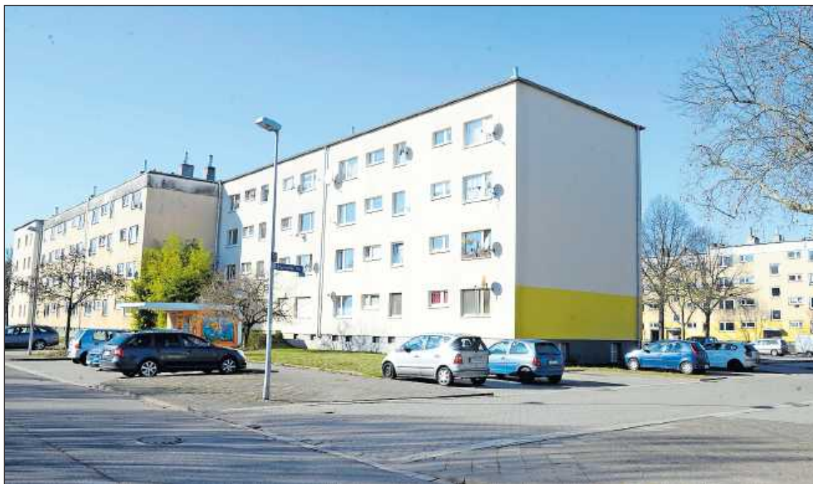
Blick in die Bayreuther Straße: Die Wohnungen in den Bereichen ganz links und ganz rechts (im Hintergrund) gehören zu den Blöcken, die saniert werden sollen. Fast 500 Menschen leben hier.
